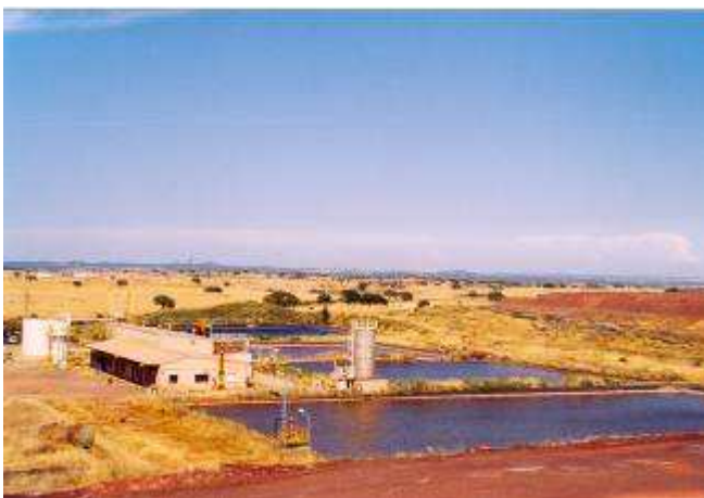
Instalaciones de tratamiento y laboratorio
