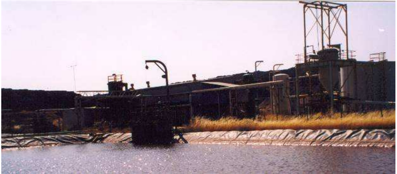
Instalaciones de limpieza, deseaireación y tratamiento con y Zinc del concentrado
