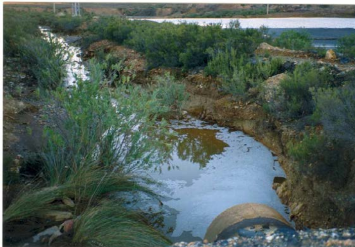
“Aguas depuradas” por la EDAR Tharsis a su paso por el paraje conocido como Chimenea Gorda (año 2002)
