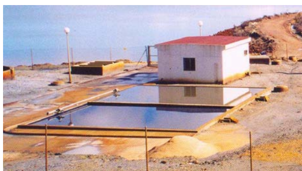
Zona de secado de lodos
