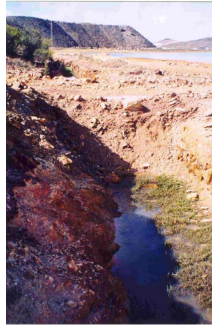
Taponamiento de canal de salida
